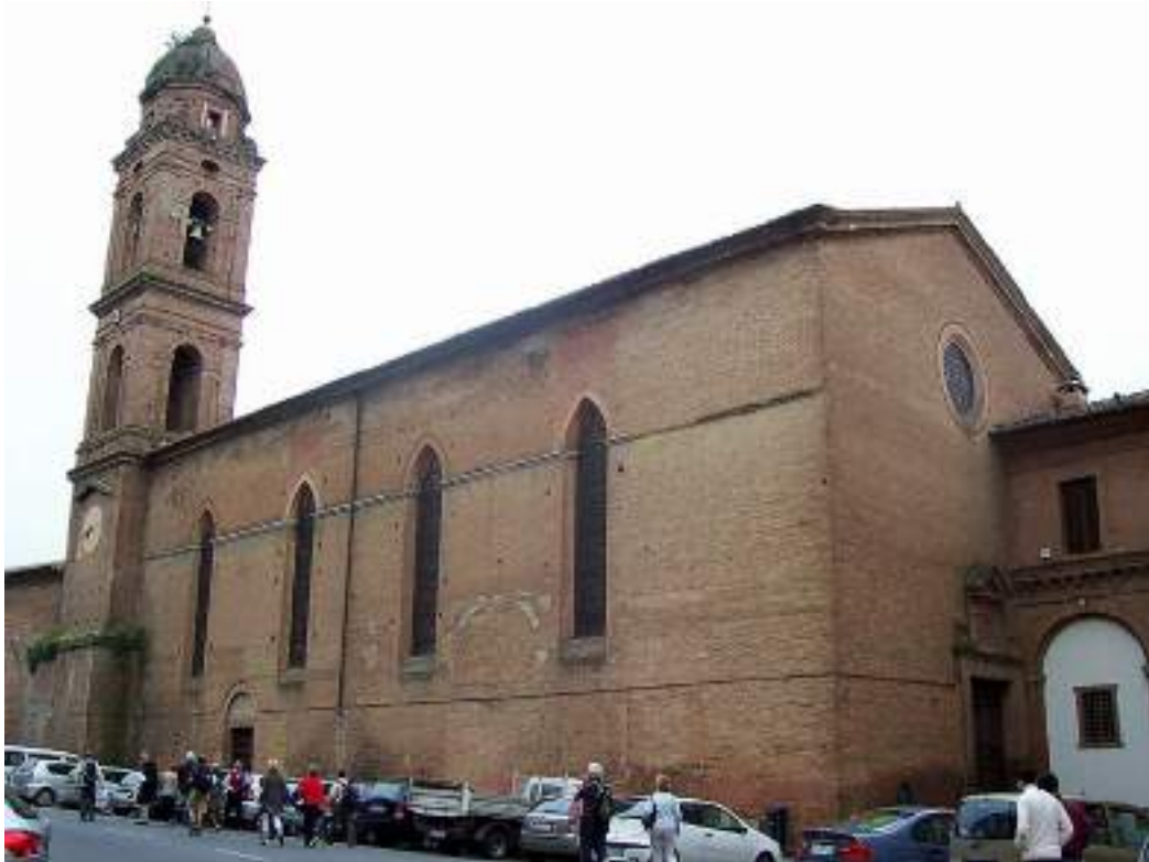
Fig. IV.1: Siena, chiesa di San Niccolò al Carmine (veduta esterna)
