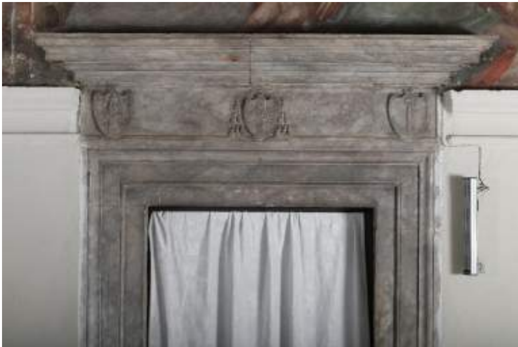
Fig. III.51: portale della cappella funebre della famiglia Piccolomini corrispondente alla cappella delle Sacre Particole, già di Sant'Andrea. Siena, convento di San Francesco, refettorio (già oratorio della compagnia di San Gherardo)
