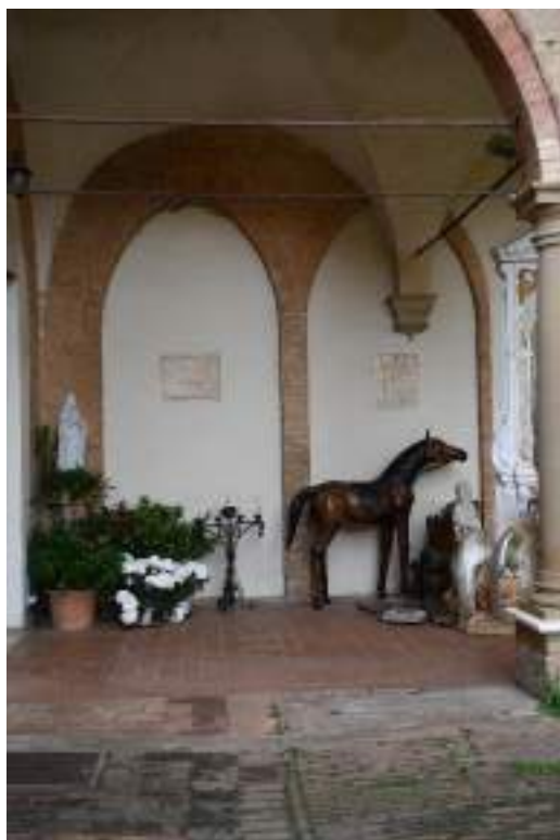
Fig. III.45: Siena, convento di San Francesco, chiostro del cimitero (particolare dei portali archiacuti tamponati retrostanti alla cappella di Sant'Antonio di Padova)
