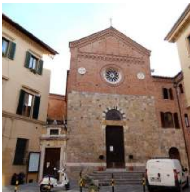
Fig. VI.2: Siena, chiesa di San Michele in San Donato (prospetto esterno) (dopo l'intervento di ripristino in stile)
