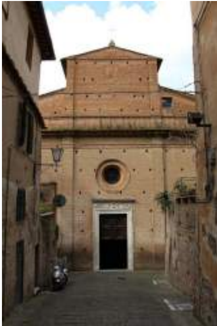
Fig. 1.27: Siena, chiesa di Santa Maria in Portico in Fontegiusta (veduta esterna)
