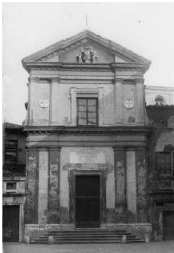
Fig. VI.1: Siena, chiesa di San Michele in San Donato (prospetto esterno) (prima dell'intervento di ripristino in stile)
