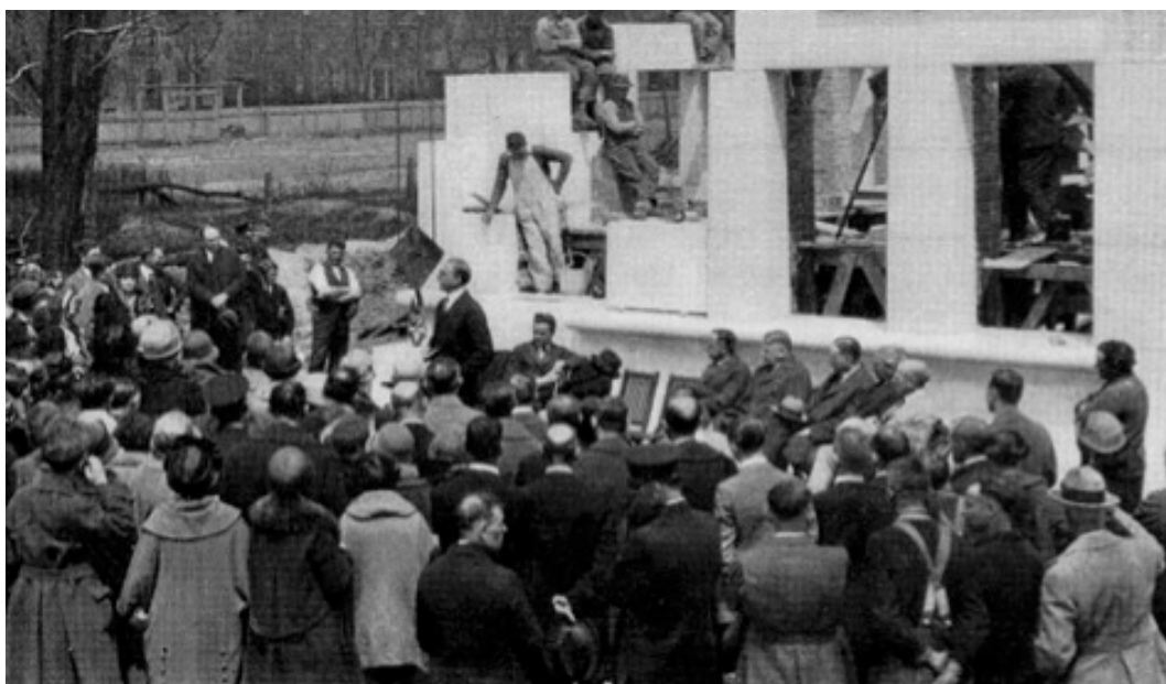
50. La posa della prima pietra del nuovo edificio del Detroit Institute of Arts, 29 aprile 1924.
