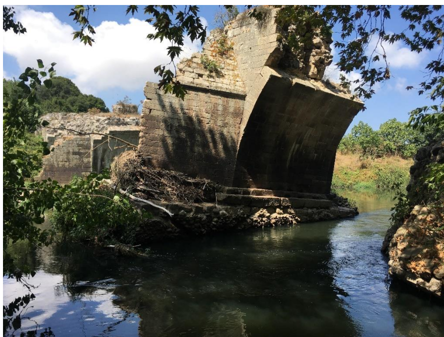
Fig. 18: Piloni del ponte sul fiume Esepo (Güvercinli Köprüsü); veduta da est.
