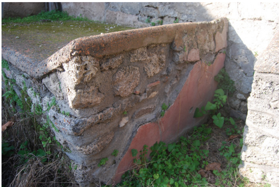
Fig. 7 Triclinio, con dettaglio dell'intonaco di rivestimento
