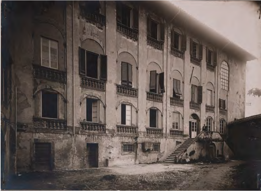
Fig. 19. Il fronte posteriore del Palazzo della Carovana prima del restauro del 1931-32. Roma, ICCD, Gabinetto Fotografico Nazionale, Fondo GFN, Eo13839.
