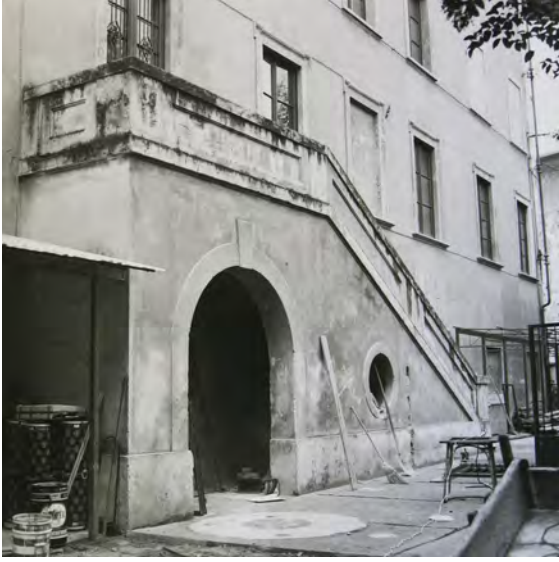
Fig. 39. La scala esterna a servizio del lato nord-occidentale del Palazzo, foto del 15 febbraio 1974. SABAP-Pi, Fabbricato della Carovana f. 121 m. 206-207 c. I, fasc. Demolizione scala esterna .
