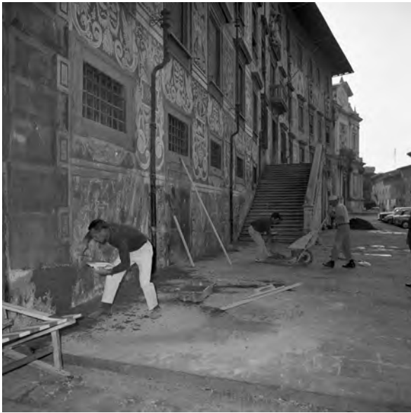
68. Il Palazzo della Carovana durante il restauro del 1973-1974. SABAP-PI, Fototeca SBAAAS_PI, neg. 24861.
