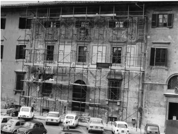
60-62. Il Collegio Puteano durante il restauro del 1971-1972. SABAP-PI, Archivio Restauri, Pi - Collegio Puteano - Rest. Lorenzetti 1972, neg. 20343, neg. 20342, neg. 20344.
