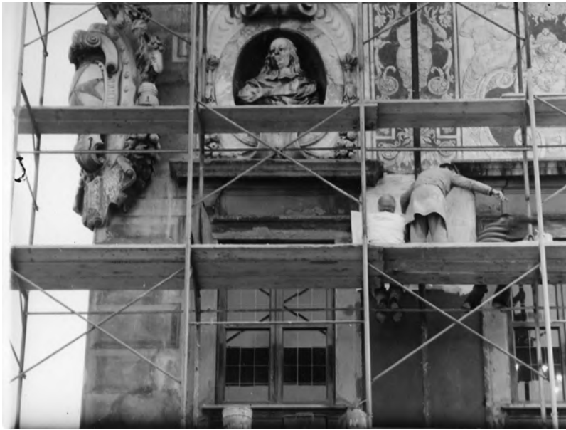
52-53. Il Palazzo della Carovana durante il restauro del 1970-1971. SABAP-PI, Archivio Restauri, Pi - Palazzo Carovana - Facciata - Rest. Lorenzetti 1968, neg. K941 e neg. K942.
