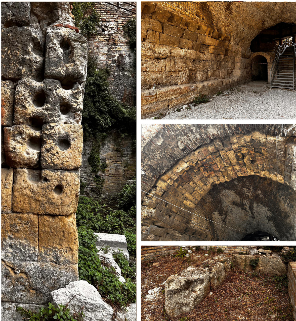
Figura 41 – Arco Bonarelli (da sinistra a destra); 1) stipite est; 2) lato ovest; 3) arcata superiore; 4) muro in opera quadrata H (Foto E. Iacopini)
