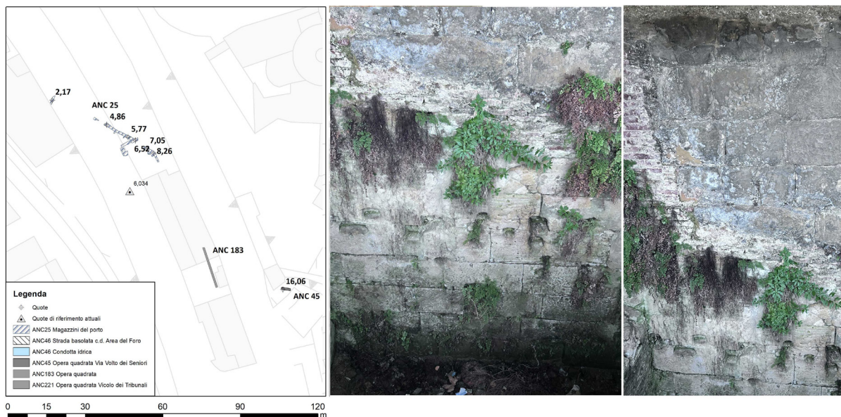
Figura 50 – Planimetria delle strutture affacciate sul Lungomare Vanvitelli (E. Iacopini); tratto delle mura tra Piazza Dante e via Giovanni XXIII; foto centrale paramento originale con sette filari in basso, a destra parte alta con rifacimento successivo (Foto E. Iacopini)
