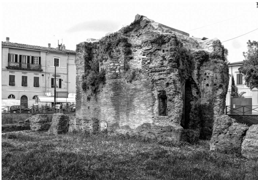
Fig. 5 - Ambiente 4, parete ovest
