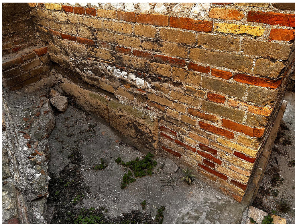
Figura 36 – Muro in opera quadrata B, angolo con A (Foto E. Iacopini)
