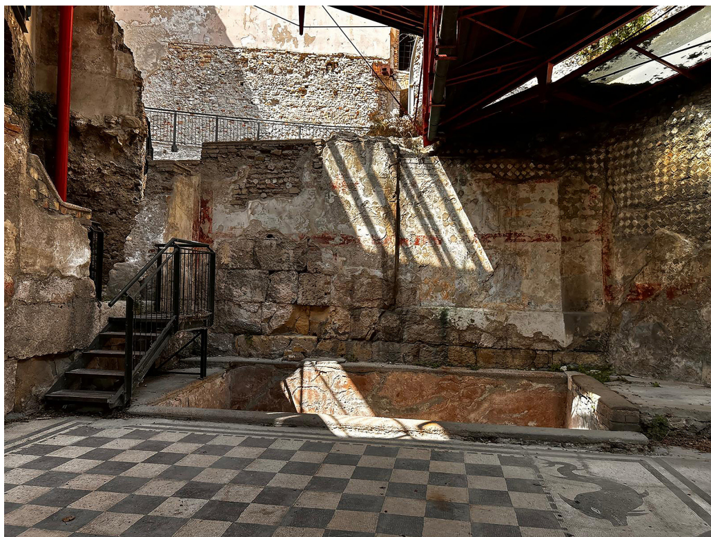
Figura 35 – Muro in opera quadrata B (Foto E. Iacopini)
