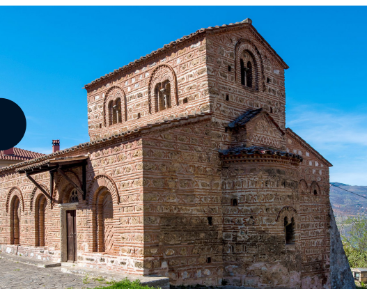
5.3 Kastoria, Santi Anargiri, prospetto sud-orientale. (foto dell'autore)
