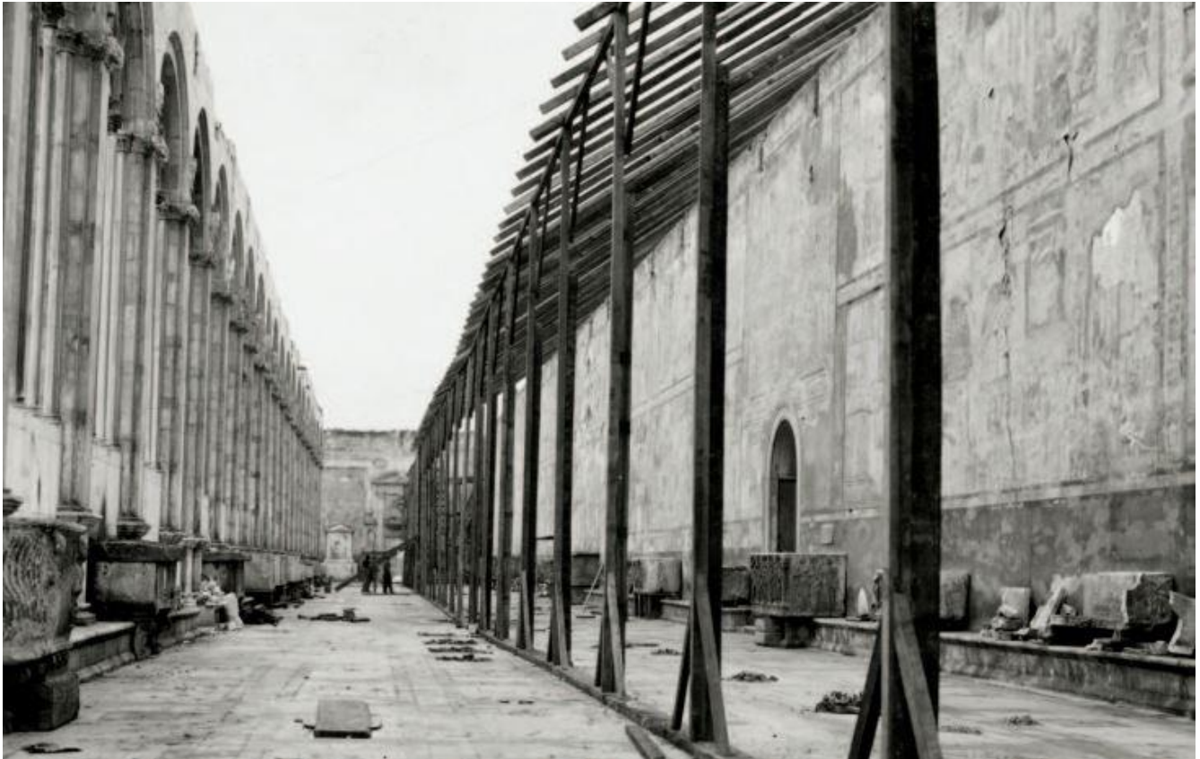
Fig. 7 I lavori di copertura provvisoria degli affreschi del lato nord Camposanto di Pisa nell'autunno 1944 (Cinquanta monumenti danneggiati dalla guerra)
