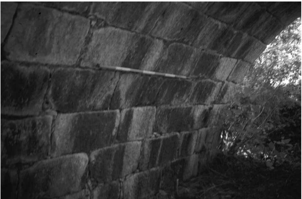
133. Vallone Ruvolo. Arco del ponte in pietra prossimo al sito 69- Vallone Ruvolo , lungo la Via n. 29.
