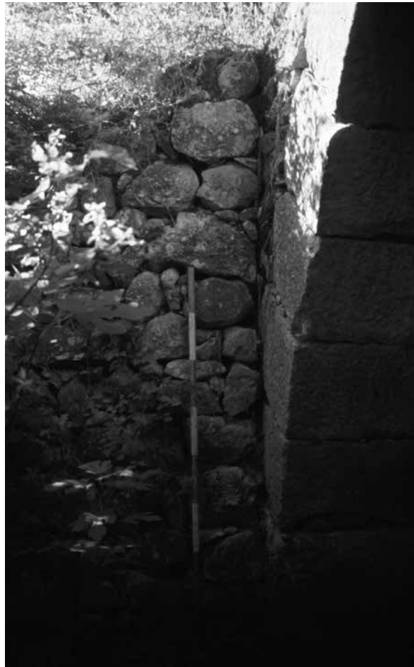
135. Vallone Ruvolo. Spalla del ponte in pietra prossimo al sito 69-Vallone Ruvolo.
