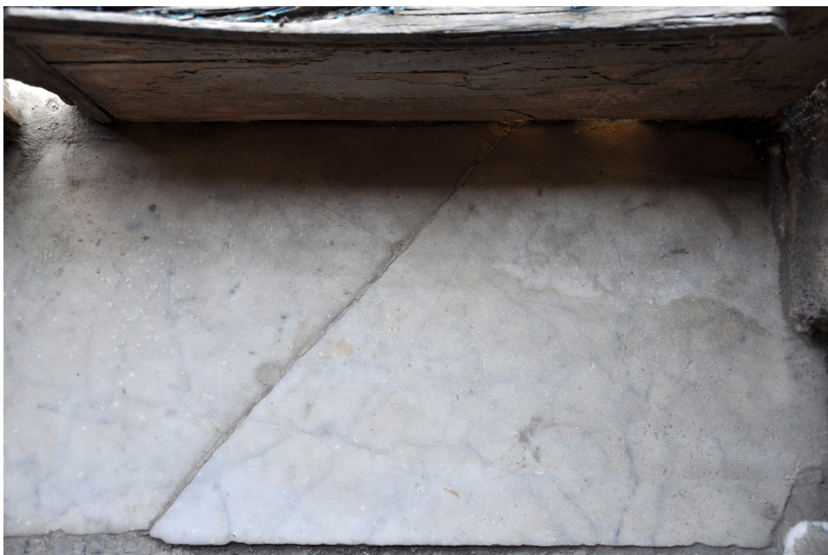
D) La porzione orientale della soglia di accesso all' atrium 24.
